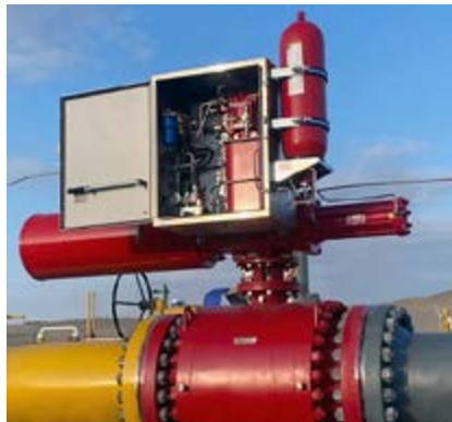
Figura 1 (Derecha): Ejemplo de actuador de prueba de carrera parcial (PST) gas-hidráulico compatible con SIL 3 instalado recientemente en servicio de interrupción de línea.
