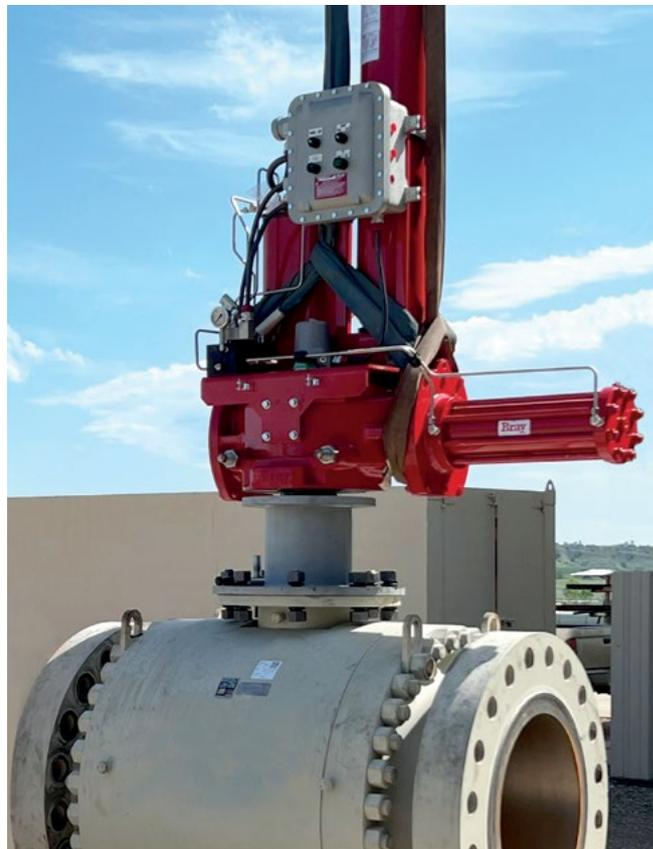
*Atuador eletro-hidráulico de emissões zero e conjunto de válvula esférica montada em munhão sendo preparados para comissionamento da tubulação.*
