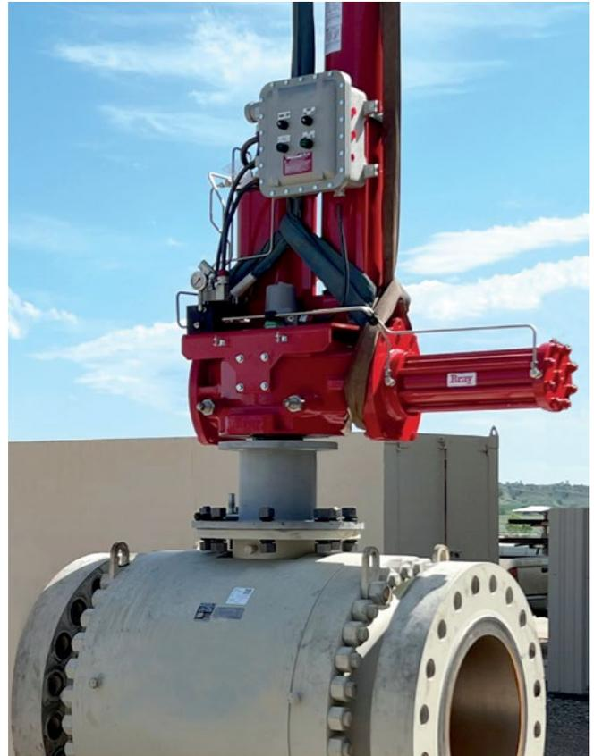
*Actuador electrohidráulico de cero emisiones y ensamblaje de trunnion - válvula de bola montada sobre muñón que se está preparando para la puesta en marcha de tuberías.*
