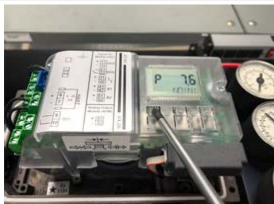
**Etapa 3** Quando estiver no modo de configuração, o parâmetro 1 é exibido no canto inferior esquerdo da tela do posicionador. O parâmetro 1 permite ao usuário selecionar o tipo de atuador que está sendo emparelhado com o dispositivo.
