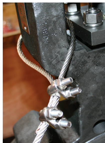
图4： 钢丝绳牢固环绕在阀体颈部。
