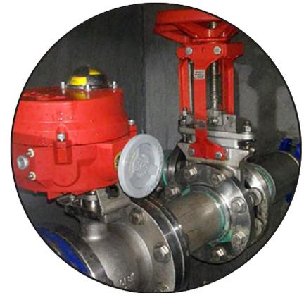
*Las válvulas de cuchilla, la válvula de control de bola segmentada y el actuador eléctrico de Bray proporcionan un cierre total y modulación precisa.*
