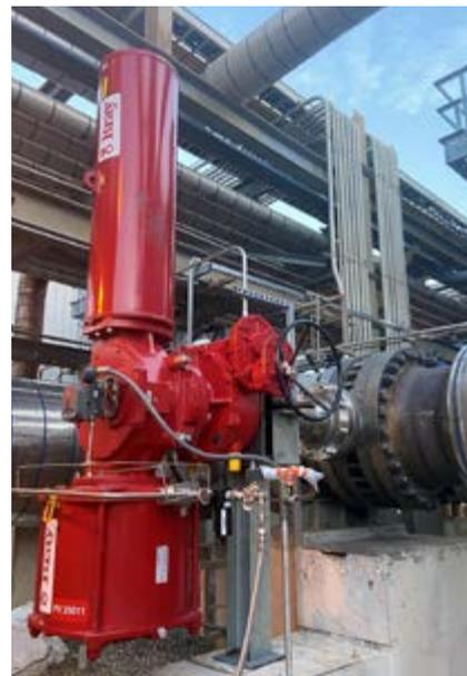
**Válvula mariposa de triple excentricidad Tri Lok instalada con actuador neumático yugo escocés serie 98 y posicionador digital. Los dos paquetes de válvulas mejoraron significativamente la eficiencia operativa en el proceso de deshidrogenación de propano.**
