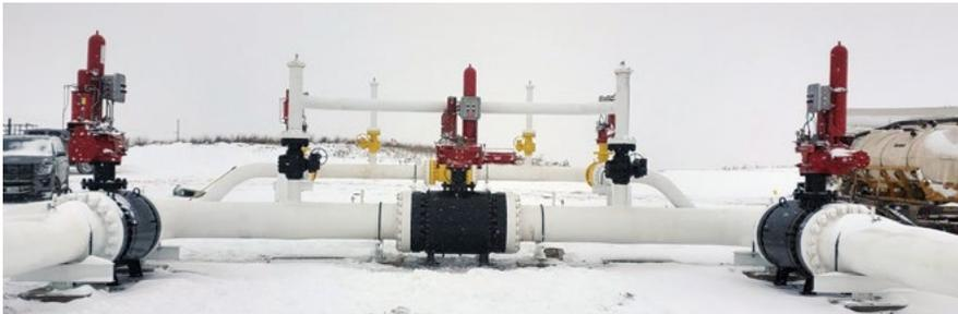
**(Arriba y a la Derecha) Servicio Line Break:** Actuadores S98EH doble efecto, alimentados con 24 VDC, con acumulador de energía almacenada, montados sobre válvulas de bola.
