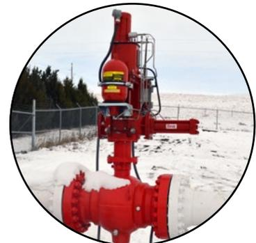
*Actuador de doble efecto Bray Serie 98EH con acumulador de energía almacenada, montado sobre válvula de bola para transmisión de gas.*
