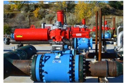
**Servicio de Conmutación:** Actuadores S98EH de retorno por resorte, alimentados con 120 VAC, montados sobre válvulas de bola utilizadas en un colector de gasoducto.
