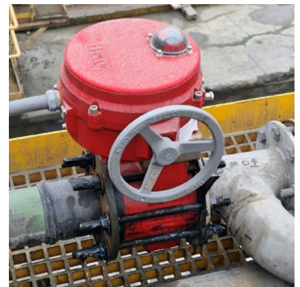
La válvula de control Bray Serie 39L con revestimiento cerámico, junto con el actuador eléctrico Serie 70, proporcionó una mayor precisión en el control y una vida útil operativa prolongada.
