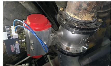
*Uno de los tres paquetes de válvula automatizada, consiste en una válvula de control de esfera segmentada S19, un actuador neumático doble acción S92, y un posicionador 6A.*
