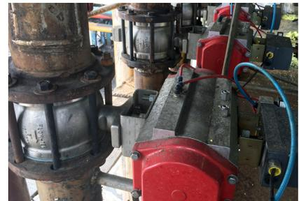
*El paquete de válvula automatizada de Bray incluye válvulas de control de esfera segmentada S19 con asientos metálicos, actuadores neumáticos S92, y posicionadores S6A.*
