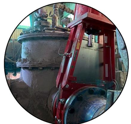
**Las válvulas guillotina Serie 762 SLURRYSHIELD® de Bray con actuador de doble acción proporcionaron una vida útil 6 veces mayor que las válvulas de la competencia.**
