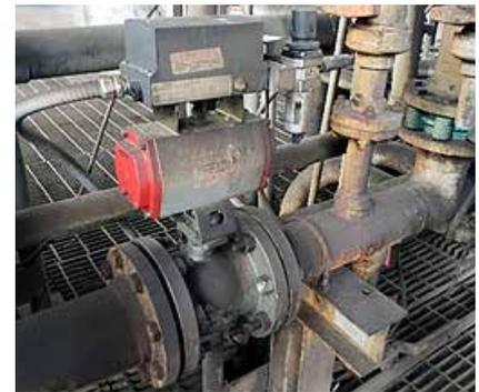
*Bray suministró una válvula de control optimizada y un paquete de automatización, que incluía una válvula de bola segmentada Serie 19L, actuador piñón cremallera Serie 93, y posicionador w/diagnóstico Serie 6A.*
