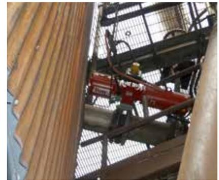
*Paquete de válvula mariposa Serie 41 ON/OFF automatizada con Bray Serie 98 en proceso de clarificación de lodo*
