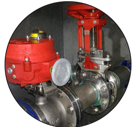
Válvulas guilhotina Bray, válvula de controle esfera segmentada e atuador elétrico fornecem bloqueio absoluto e modulação precisa.
