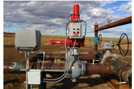
Serviço de Comutação — Alimentado por 120VAC Atuadores de retorno por mola S98EH montados em válvulas de esfera utilizadas em um manifold de duto.
