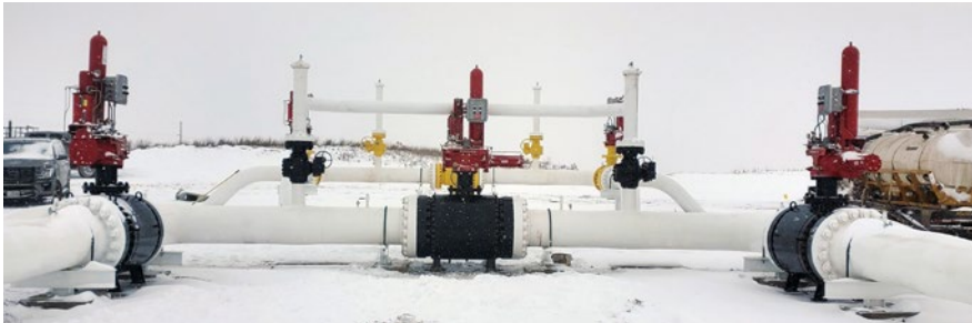
(Acima e à Direita) Serviço de Quebra de Linha — Alimentado por 24VDC atuadores S98EH de duplo efeito com acumulador de energia armazenada montado em válvulas de esfera.
