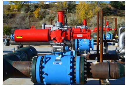
Serviço de Comutação — Alimentado por 120VAC Atuadores de retorno por mola S98EH montados em válvulas de esfera utilizadas em um manifold de duto.
