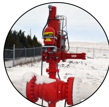
Atuador de dupla ação Bray Série 98EH com acumulador de energia armazenada montado na válvula de esfera de transmissão de gás.
