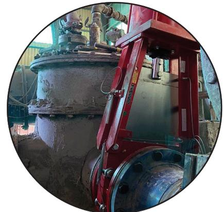
**As válvulas guilhotina Bray Série 762 SLURRYSHIELD® com atuador de dupla ação proporcionaram 6 vezes mais vida útil em comparação às válvulas concorrentes.**
