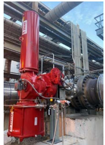
**Vanne papillon Tri Lok à triple excentration installée avec un actionneur pneumatique Scotch yoke série 98 et un positionneur numérique. Les deux ensembles de vannes ont considérablement augmenté l'efficacité opérationnelle dans le processus de déshydrogénation du propane.**
