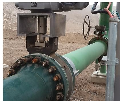
*La Vanne Papillon à siège métallique double excentration a fourni plus de 5 ans de service continu sans défaillance et sans besoin d'entretien.*
