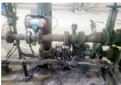
La S19L Bray fonctionne en continu depuis plus de 24 mois sur cette application sévère.
