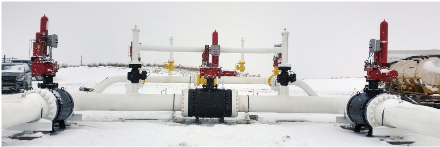
（上图和右图）管线切断——安装于球阀上的S98EH系列双作用执行机构（内置蓄能器，24VDC电源）
