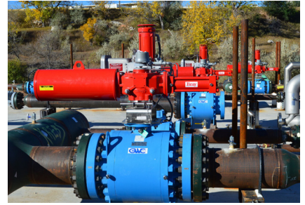
开关——安装于管道集管球阀上的S98EH系列弹簧复位执行机构（120VAC电源）。
