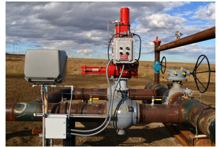
开关——安装于管道集管球阀上的S98EH系列弹簧复位执行机构（120VAC电源）。
