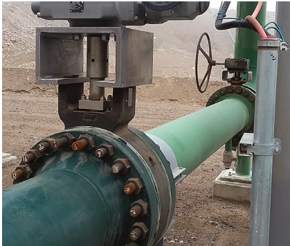
McCannolok金属阀座双偏心蝶阀已连续工作超过五年，无故障且无需维护。
