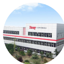
Installation de recherche et développement CHINE
